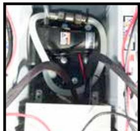
Le filtre d'eau Claire est situé sous le compartiment à batteries. Celui-ci doit être vérifié et nettoyé à intervalles réguliers.
